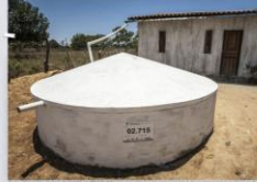
Sistema de Placas ferro-cimento / Modelo - P1MC
